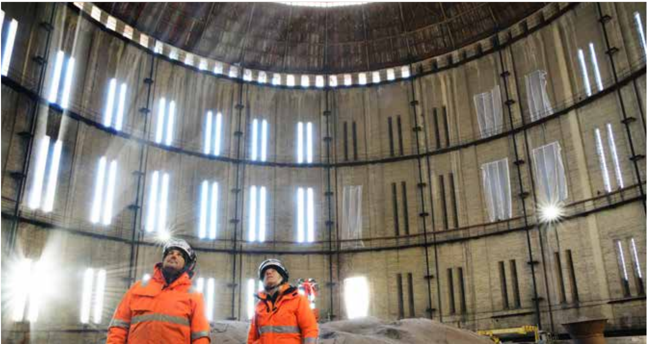
Gasklockan 2, Norra Djurgårdsstaden, Stockholm
